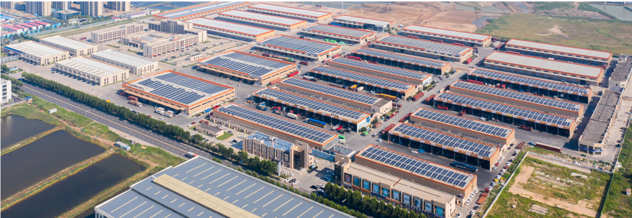
青岛公路港屋顶光伏项目
