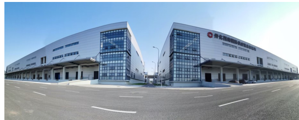
传化西南国际供应链总部基地
