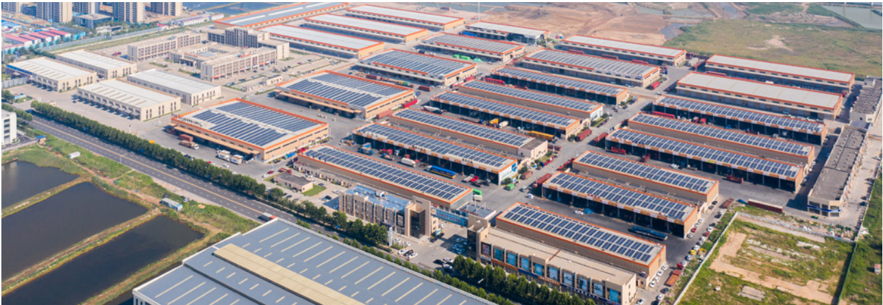
青岛公路港屋顶光伏项目
