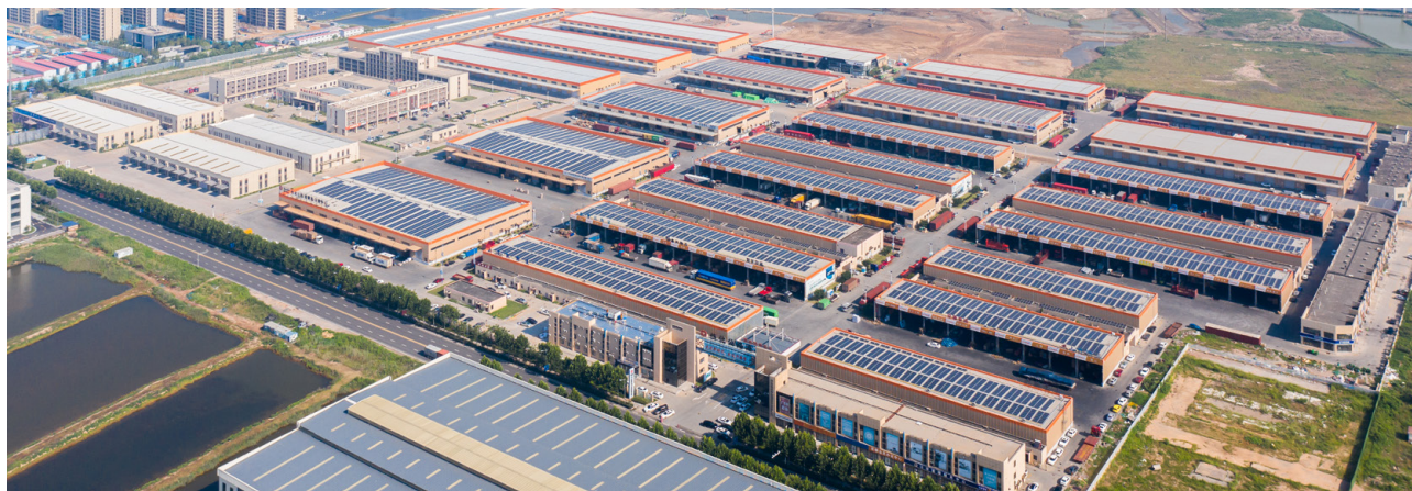
青岛公路港屋顶光伏项目
